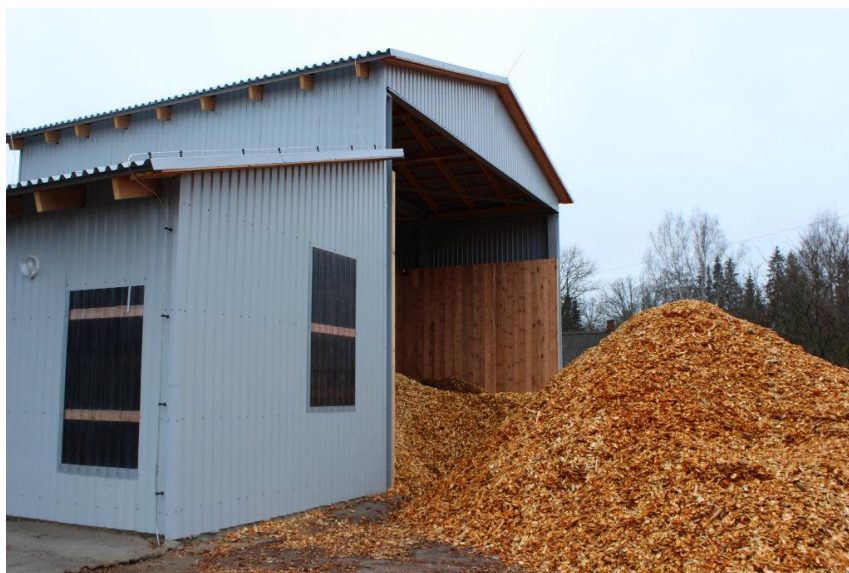
2015. gadā rekonstruētā katlu māja Skolas ielā 9, Lubānā. Foto: Ligita Pētersone
